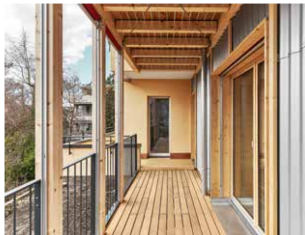
Mit grosszügigen Terrassen erweitert der Anbau auch den Aussenraum der neuen Wohnungen.
