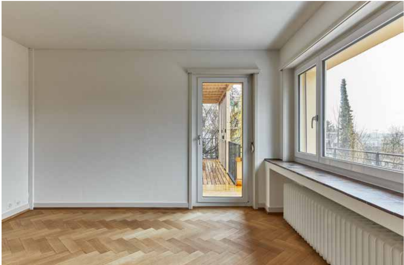
Bausubstanz und Charakter des alten Hausteils wurden erhalten, Fischgrätparkett und grosszügige Fensterbänke zeugen vom Baujahr 1937 . Die Kunststofffenster aus den 1990er-Jahren können zukünftig ohne grossen Aufwand ersetzt werden.
