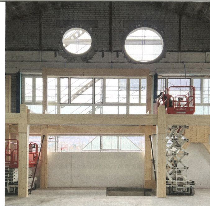
Re-Use als Formprinzip: schwere Schachtringe aus dem Tiefbau werden als kreisrunde Fenster eingesetzt und bleiben so als Umbau-Spuren ablesbar.
