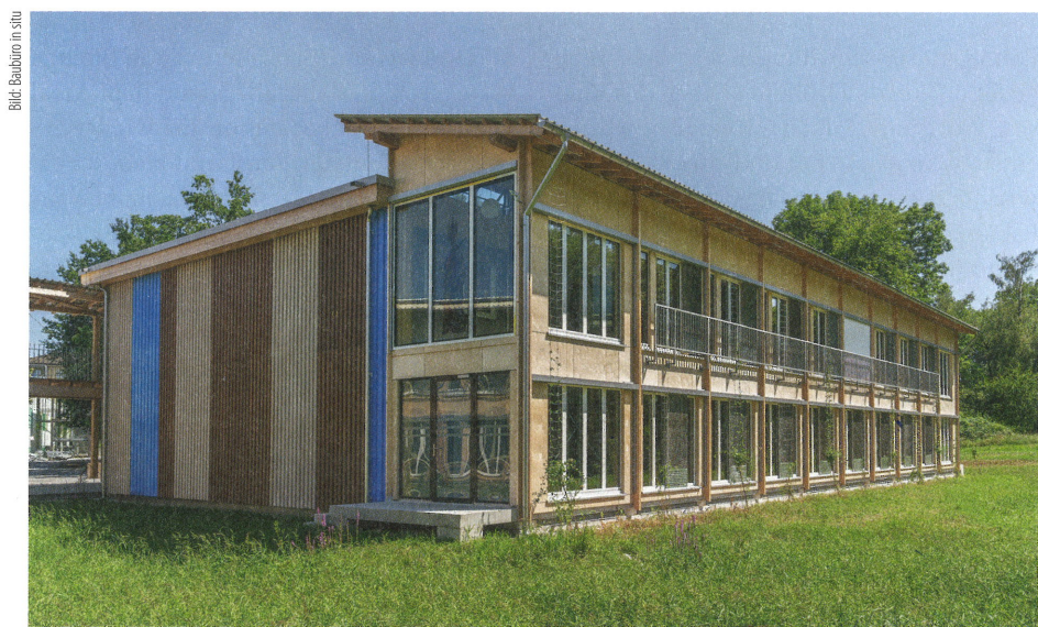
Bestehende Containermodule wurden mit Holz, Holzfaserdämmung und wiederverwendeten Blechen neu verkleidet. Eine vorgelagerte Klimazone aus Holz und Re-Use-Fenstern verbessert Komfort und Energieeffizienz.
