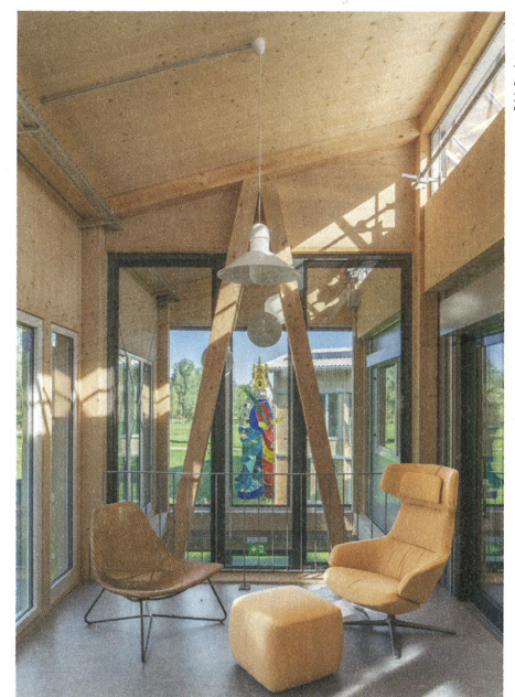
Klimazone im 1. OG: Raum aus wiederverwendeten Fenstern und sichtbarer Holzkonstruktion.
