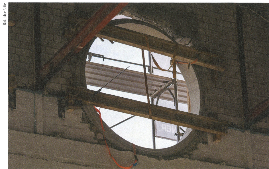
Schachtringe aus dem Tiefbau werden als runde Fenster eingesetzt.
