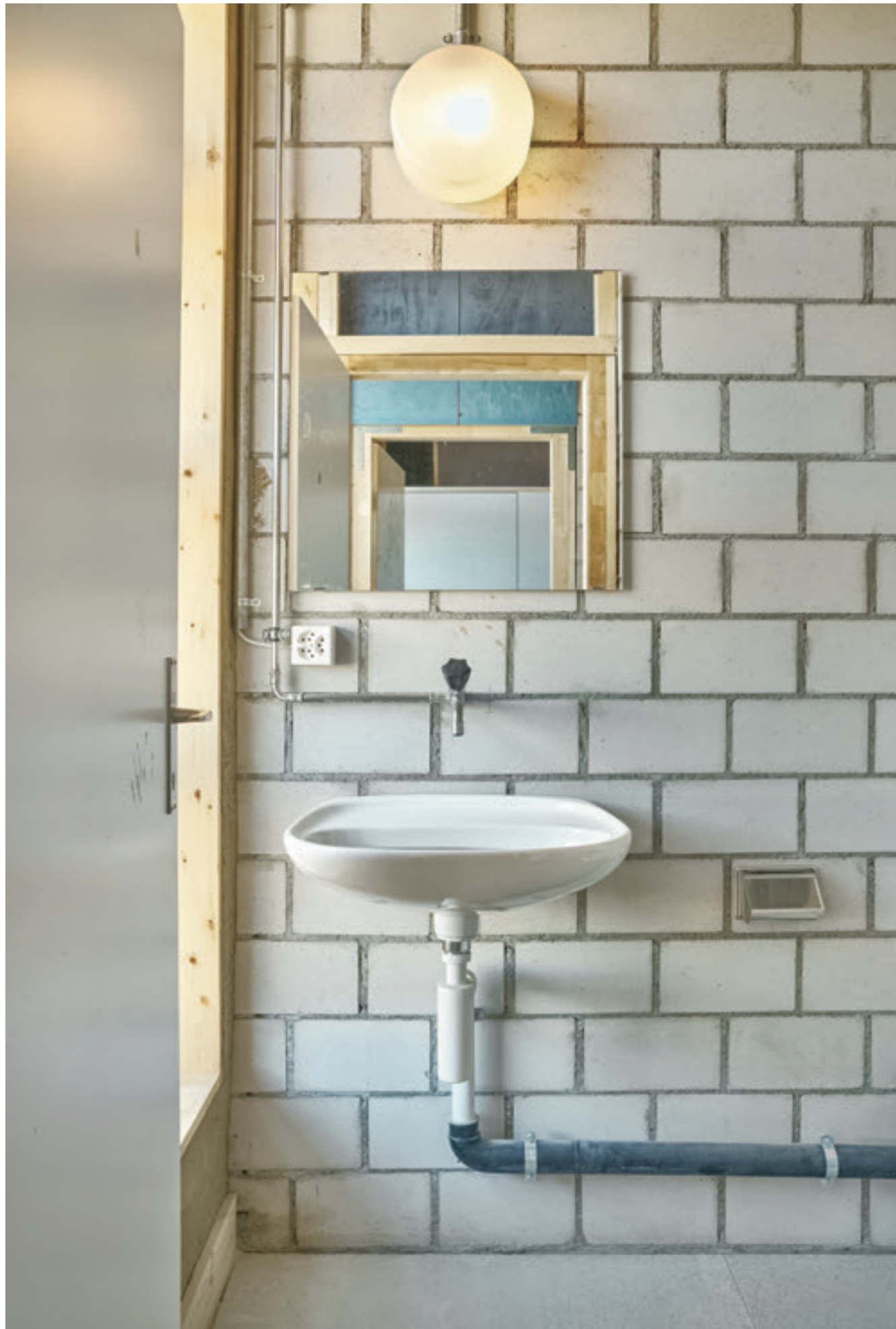
Neben Ausstattungsgegenständen und Möbeln finden auch Kleininventar und Apparaturen wie Waschbecken und Wasserhähne aus Rückbauprojekten und Bauteillagern neue Verwendung.
