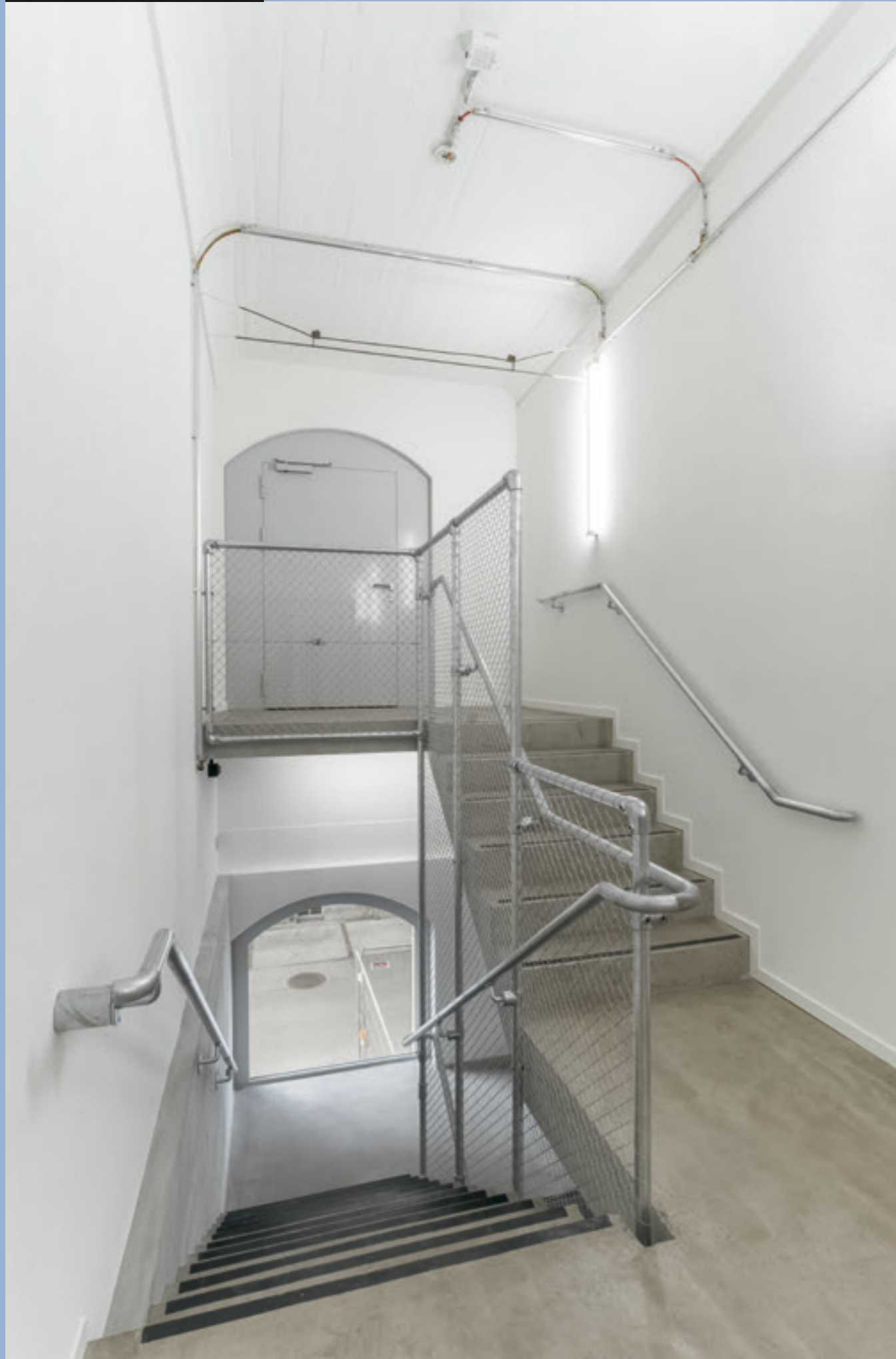
Die alten, baufälligen Treppen wurden rückgebaut und durch leichte Stahltreppenkonstruktionen ersetzt.
