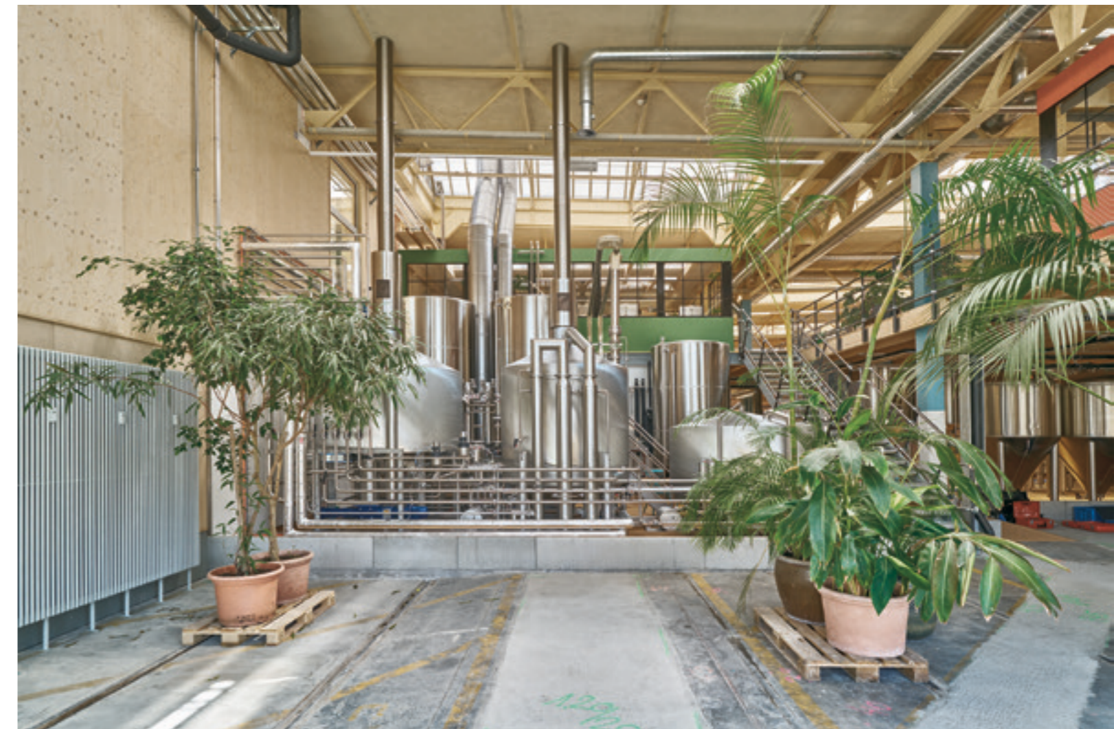
Die neuen Nutzer*innen, u. a. eine Kaffeerösterei, eine Seifenproduktion, eine Bäckerei und eine Brauerei, können ihre Räume mithilfe von modularen Trennwänden und Zwischenböden individuell anpassen.
