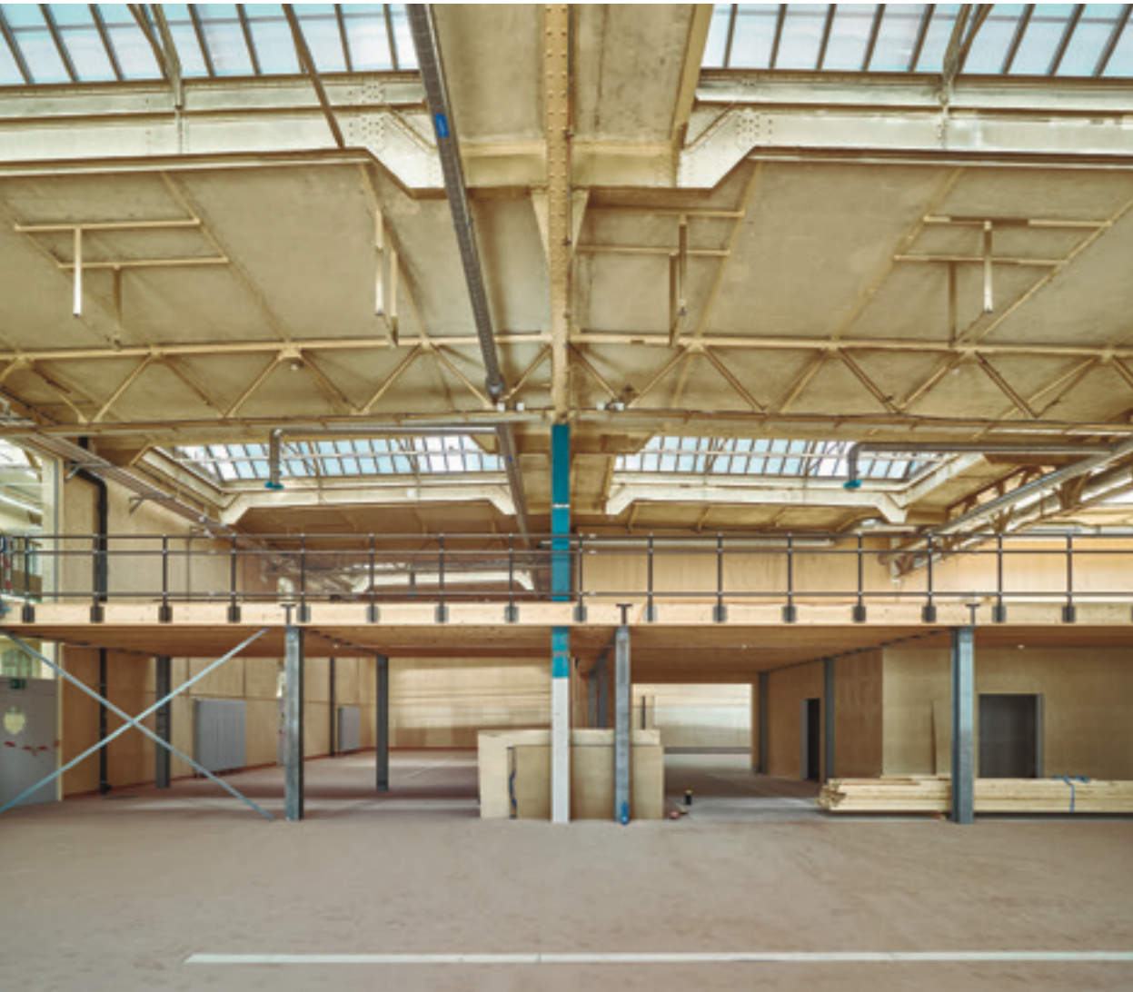
Gebäude Q mit einem neu eingezogenen Zwischengeschoss, das als Holz-Stahlträger-Konstruktion ausgeführt wurde
