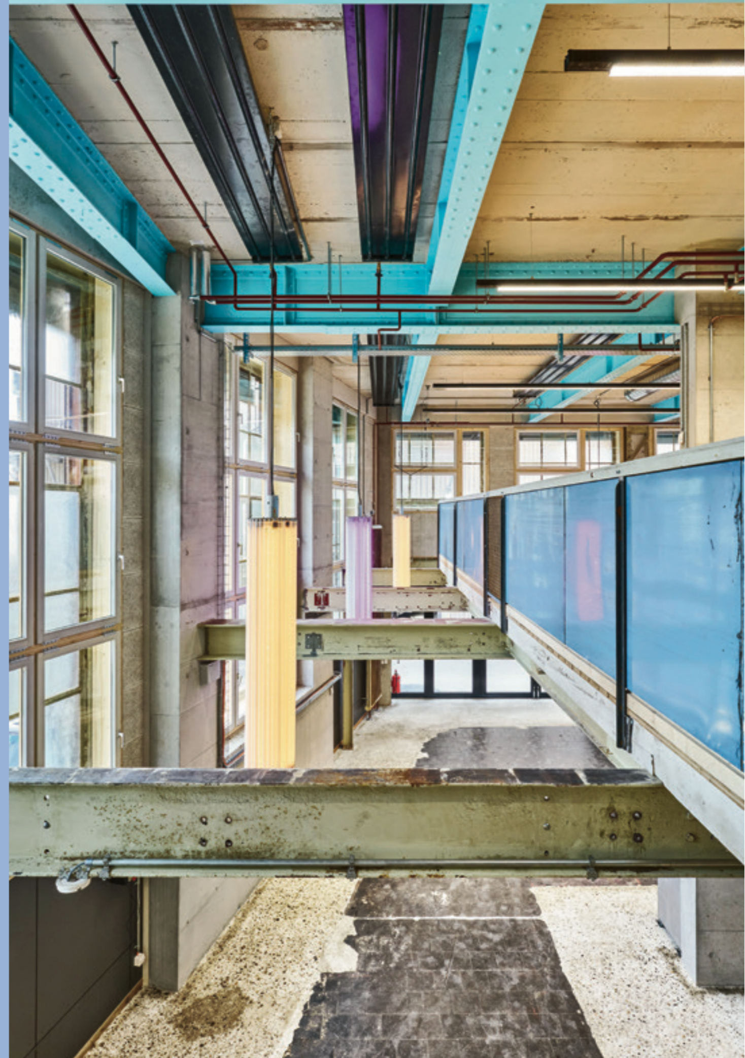
In der Halle im Erdgeschoss wurde eine neue Galerieebene aus wiederverwendeten Stahlträgern eingezogen.
