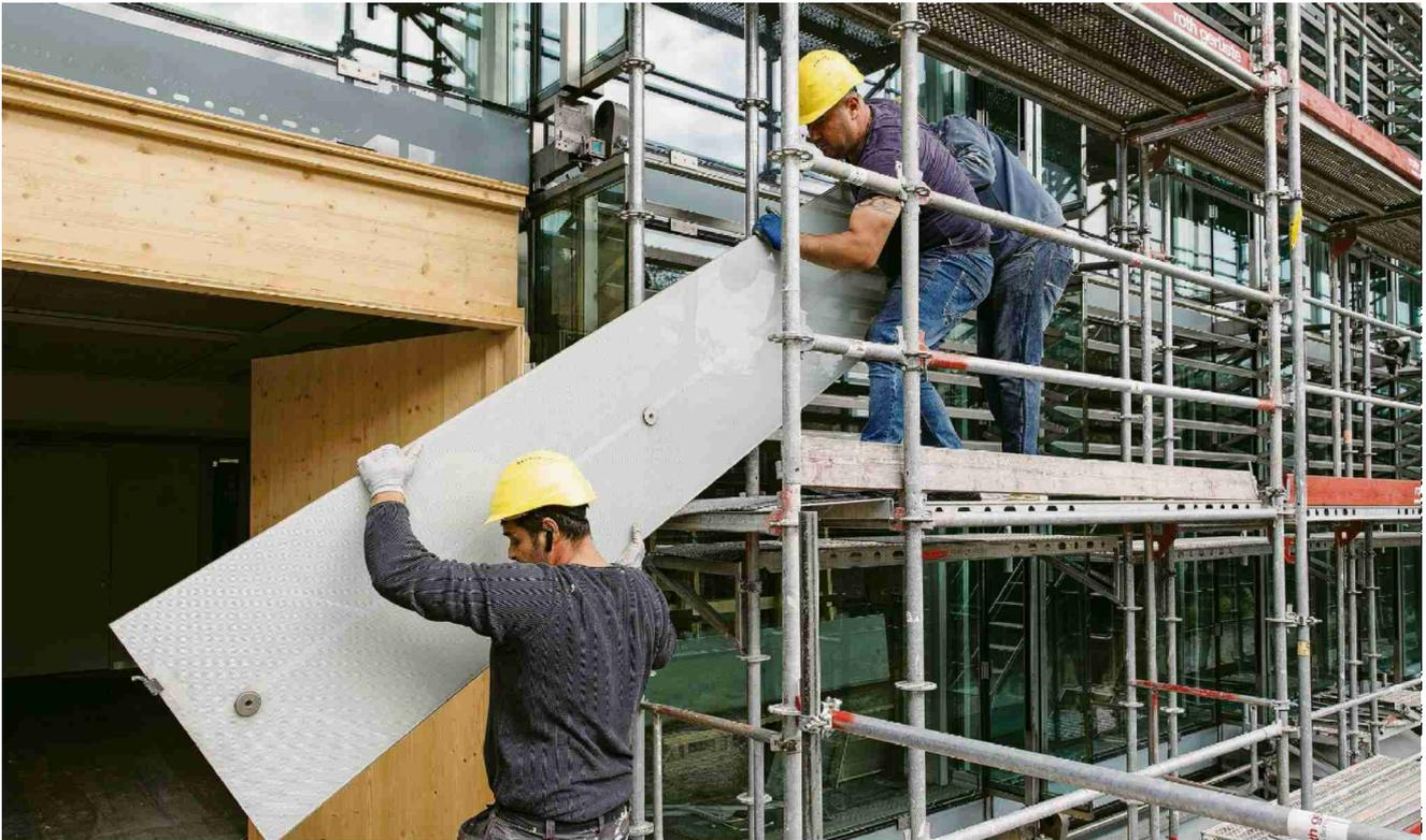
Nicht gerade handlich: Jede Lamelle ist 3 Meter lang und 50 Kilo schwer und muss von Hand abmontiert werden.
