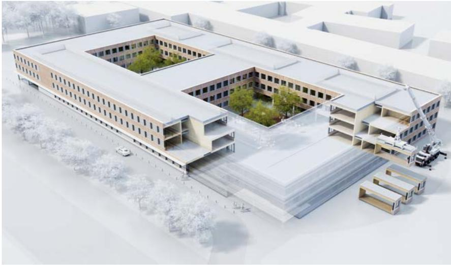
langen Module sind in Hybridbauweise erstellt. Sie tragen eine 8 cm dicke Betonschicht in den Decken. Die Hybridlösung kombiniert das geringe Gewicht und die hohe Zugfestigkeit von Holz mit der Druckfestigkeit und Masse von Beton zum optimierten Tragelement. Dies sorgt für thermischen wie akustischen Komfort sowie effektiven Schall- und Brandschutz. (cvb)
